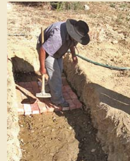
Foto 2. Agricultor colocando ladrillos en la base de la estratificadora.
