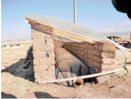
Foto 43. Vista del segundo biodigestor en construcción, para producción de biogas en vivienda de la familia Quispe.
